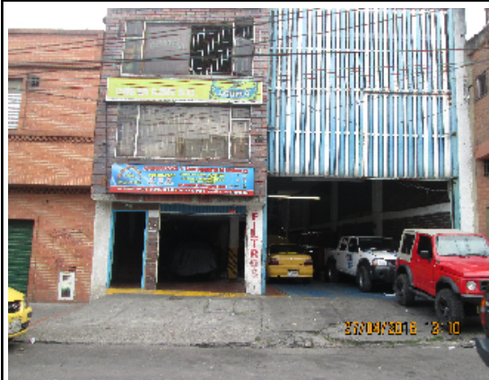
Foto No. 1. Vista frontal del predio correspondiente a la nomenclatura Carrera 55B No. 79B – 25 donde actualmente funciona el establecimiento SECARS S.A.S.
